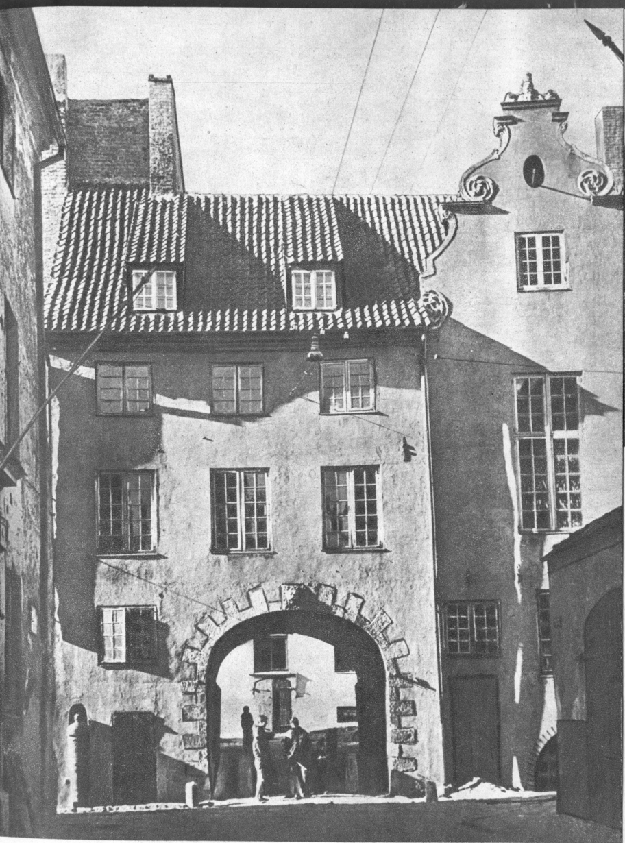
Zviedru vārti (Arhitektu nams)
