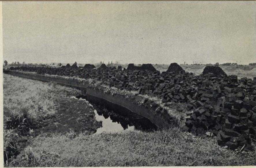
Torfmoorboden bei Kolberg; hoher Grundwasserstand, der Einbauten erschwert oder unmöglich macht. Befahrbarkeit äußerst ungünstig.
