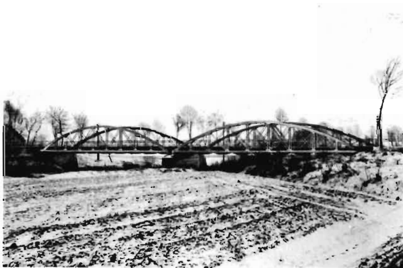
Abb. Nr. 36. Straßenbrücke über die Minge o. Prökuls (Sbj. BB 7883 Nr. 44)
