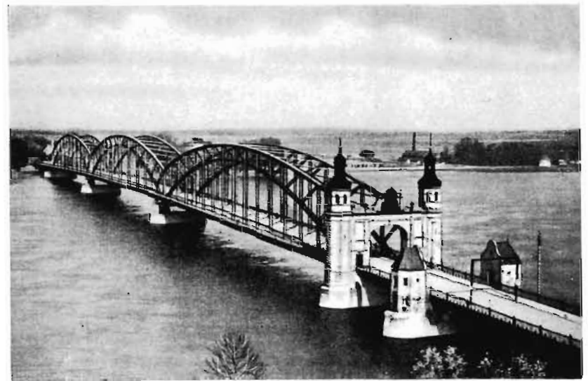
Abb. Nr. 26. Straßenbrücke über die Memel in Tilsit (BB 8081 Nr. 16)
