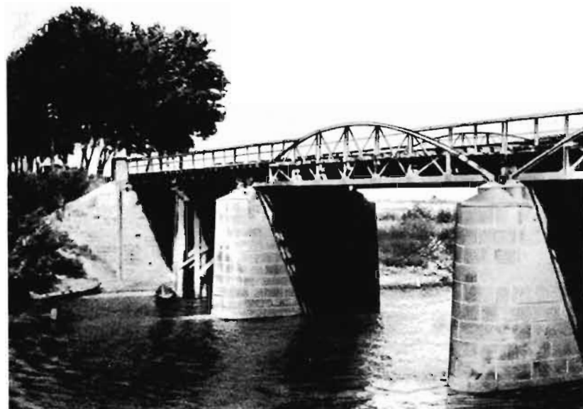
Abb. Nr. 29. Straßenbrücke über die Jura bei Mociškiai (BB 8081 Nr. 83)
