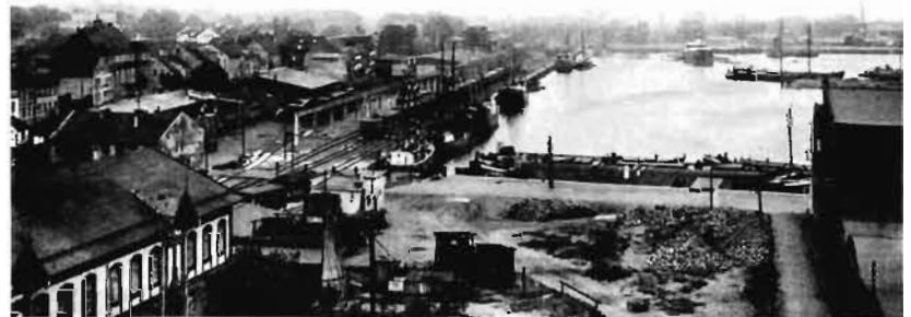
Abb. Nr. 14. Memel. Neues Hafenbecken (BB 7883)
