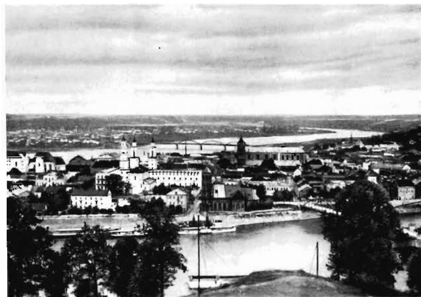
Abb. Nr. 16. Kaunas; kurz oberh. des Zusammenflusses v. Memel u. Neris. Im Vordergr. Memelbrücke (BB 8480 Nr. 18), im Hintergr. Brücke über Neris (BB 8480 Nr. 16)
