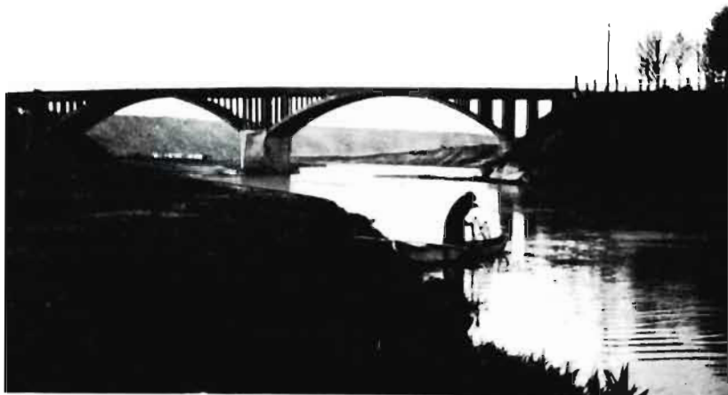
Abb. Nr. 31. Straßenbrücke s. Mariampolė über die Šešupe (BB 8379 Nr. 10)
