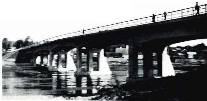
Abb. Nr. 32. Straßenbrücke über die Šventoje in Ukmergė (BB 8581 Nr. 1)
