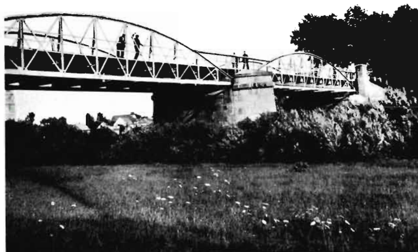
Abb. Nr. 34. Straßenbrücke über die Schirwindt in Naumiastis (Grenzbrücke) (BB 8280 Nr. 20)
