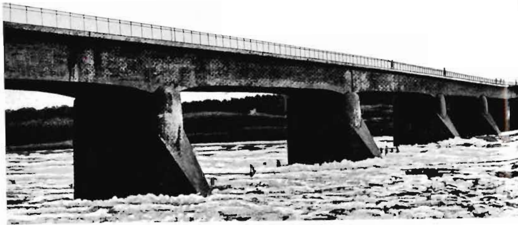
Abb. Nr. 24. Straßenbrücke über die Memel in Prienai (BB 8479 Nr. 4)
