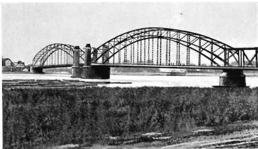
Abb. Nr. 35. Brücke über die Atmath in Ruß (BB 7982 Nr. 1)
