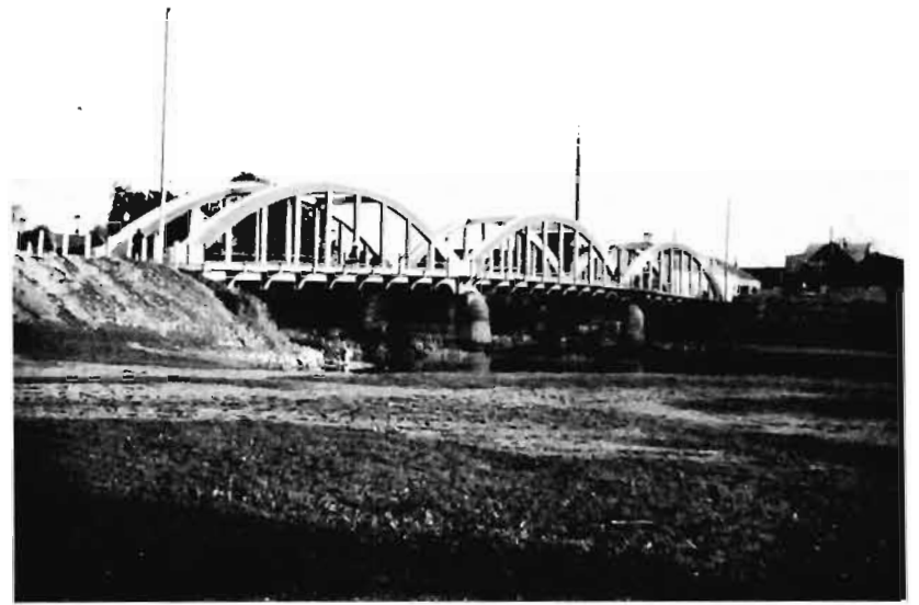
Abb. Nr. 25. Straßenbrücke über die Nevežys w. Panevėžys (BB 8483 Nr. 1)
