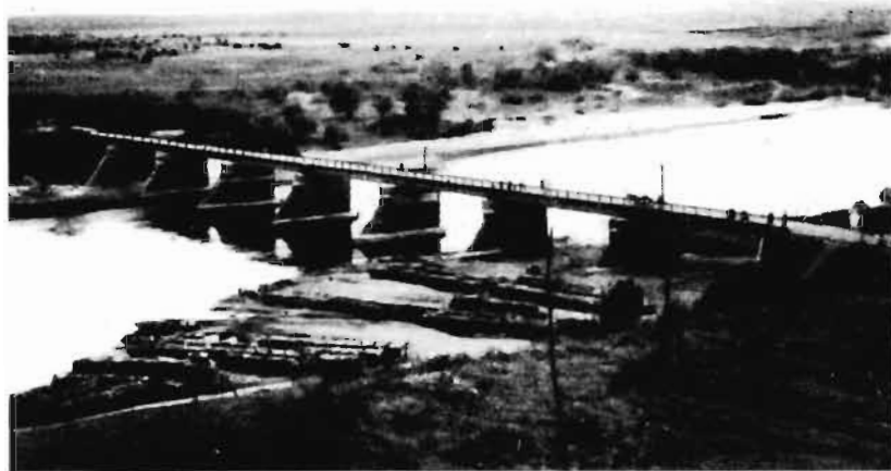
Abb. Nr. 27. Straßenbrücke über die Memel bei Merkinė, alte deutsche Kriegsbrücke (BB 8477 Nr. 2)
