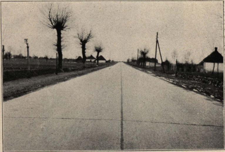
151. Betonstraße Kutno—Warschau bei Bedlno, Kr. Kutno BB 7569.
