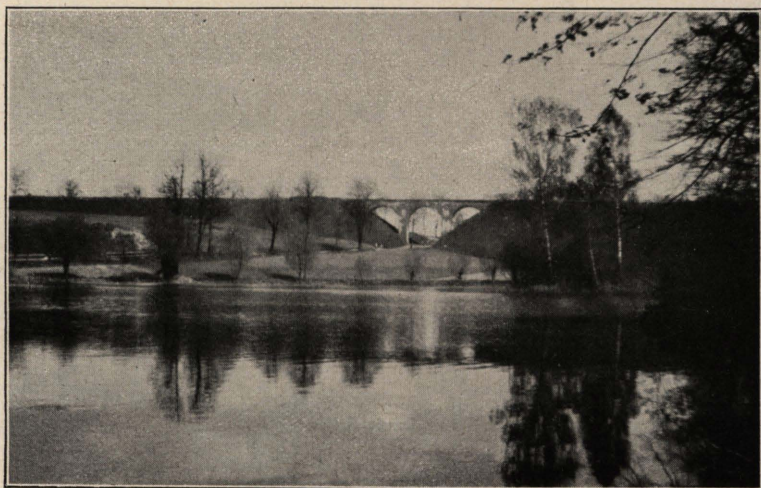
169. Eisenbahn-Viadukt über einen Weg und 2 Gewässer w. Neuthal (Nojewo), Kr. Birnbaum BB 6871/Objekt 139.
