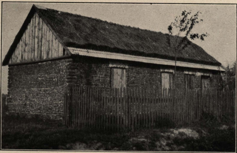
108. Haus aus Raseneisenstein an der Straße Waldwasser (Brzeziny)— Schwarzau (Blaszki), Kr. Kalisch BB 7367.
