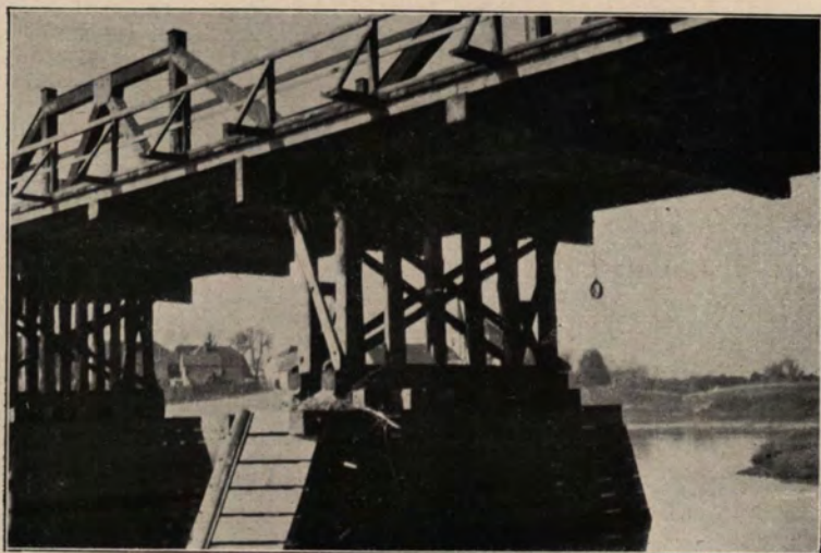
159. Pfeilerkonstruktion der neuen Warthe-Straßenbrücke in Obersitz, Kr. Samter BB 6971/Objekt 30. Dauerbehelfsbrücke aus Holz (s. Erläuterung zu Bild 158).
