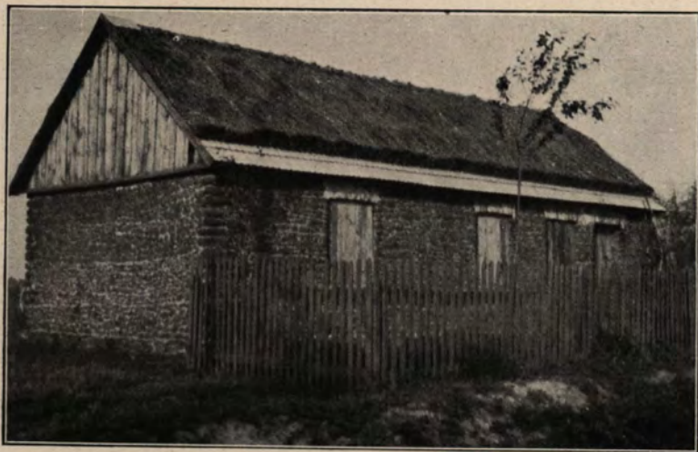
108. Haus aus Raseneisenstein an der Straße Waldwasser (Brzeziny)— Schwarzau (Blaszki), Kr. Kalisch BB 7367. Häufig an feuchten Niederungen, in denen der Raseneisenstein abgebaut wird (s. Bilder 25, 81 und 200).
