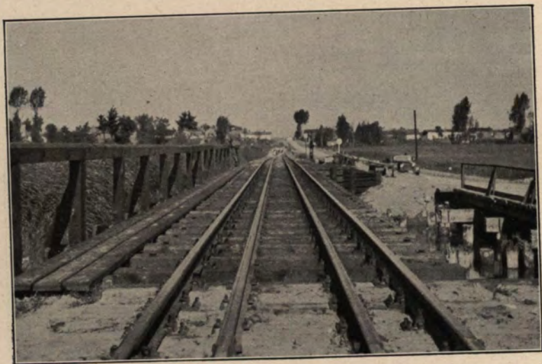
163. Vollspurgeis der Zuckerfabrik Goslawitz, dazwischen verlegt Schmalspurgleis der Kleinbahn Konin—Jablonka s. Pontnow, Kr. Konin BB 7270.
