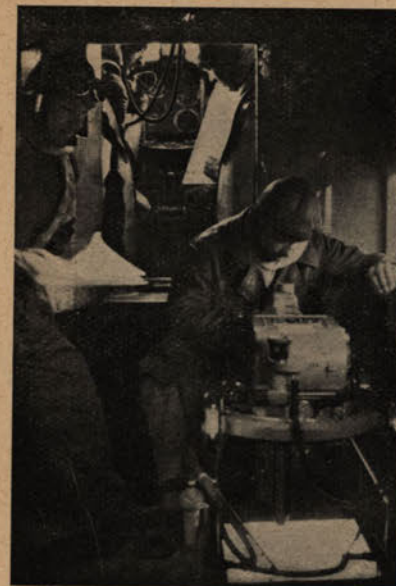
Ryc. 23. Praca obserwatora i pomocnika w samolocie pasażerskim przy kamerze automatycznej.
