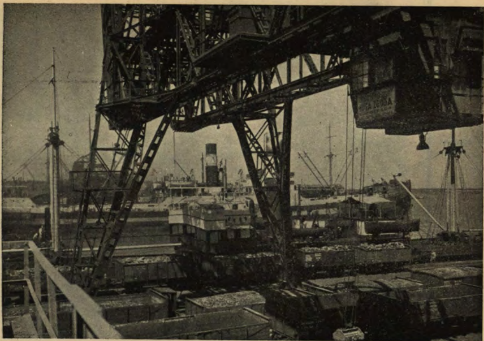
GDYNIA: Port węglowy. Kohlenhafen. Port de charbon.
