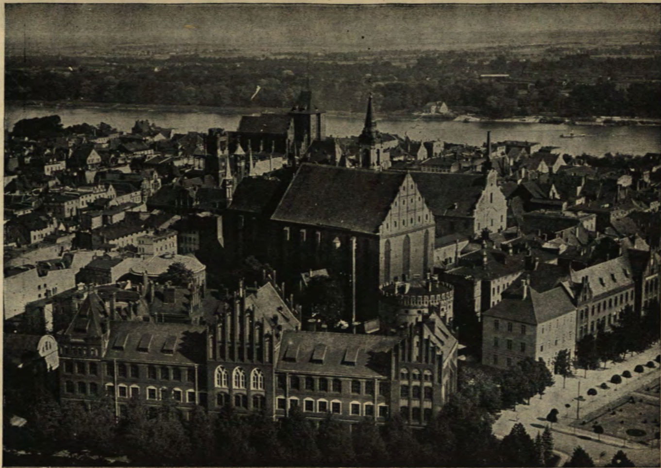
TORUŃ: Widok ogólny. Gesamtansicht. Vue générale.
