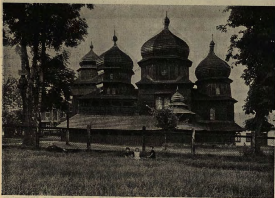
DROHOBYCZ: Cerkiew św. Jura z 1592 r. St. Georg holzkirche vom j. 1592. Eglise en bois de St. George 1592.
