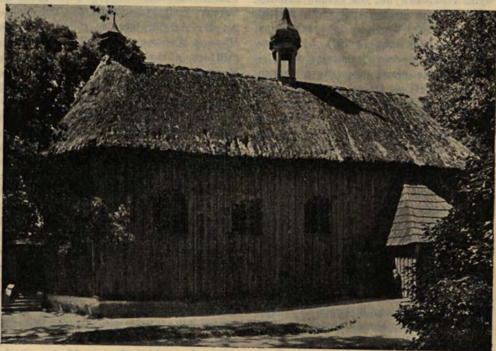
LÓDŹ K. POZNANIA: Kościół drewniany słomą kryty. Eine Holzkirche mit Stroh bedeckt. Une petite eglise en bois couverte de paille.
