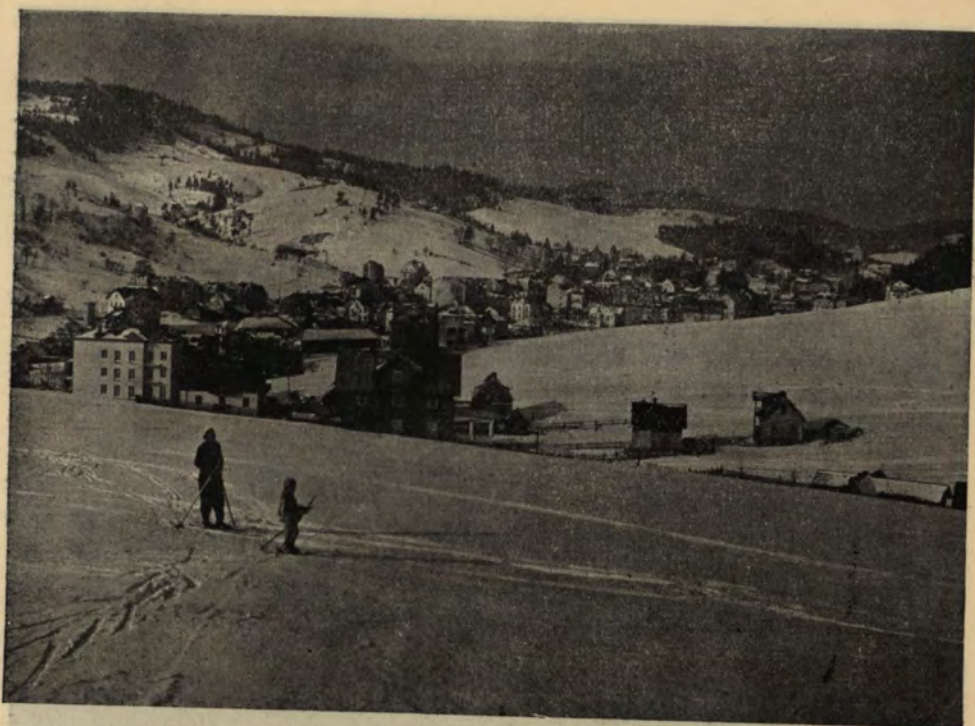
KRYNICA: Widok ogólny. Gesamtansicht. La vue générale.
